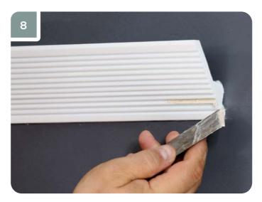
Зашпаклевать оставшееся после удаления финишного гвоздя отверстие с помощью финишной шпаклевки для внутренних работ.
