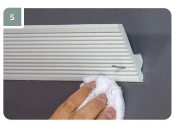
Удалить излишки клея ветошью, смоченной водой — при использовании клея «Европласт Монтажный», ацетоном — при использовании клея «Европласт Универсальный».
